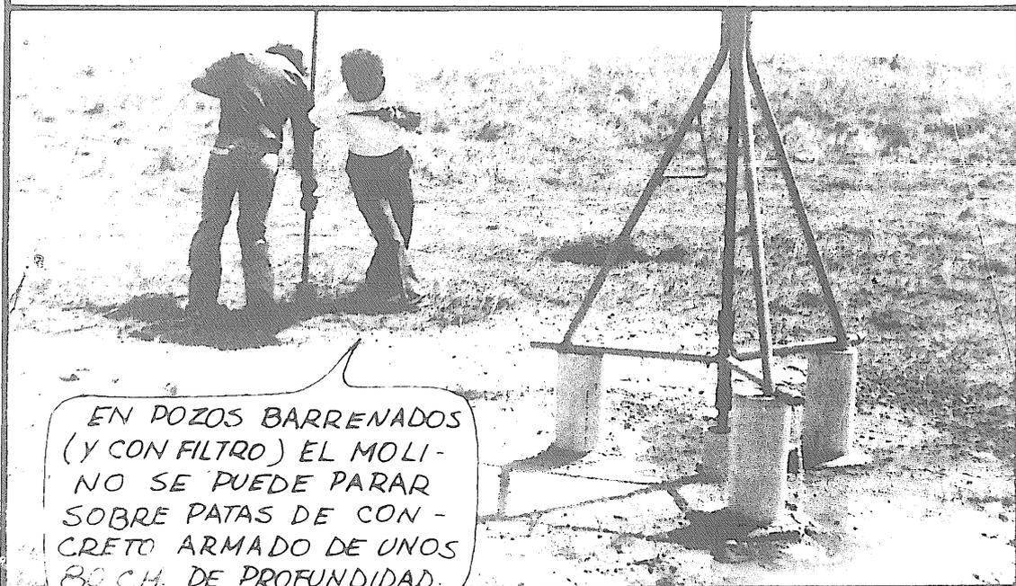
EN POZOS BARRENADOS (Y CON FILTRO) EL MOLINO SE PUEDE PARAR SOBRE PATAS DE CONCRETO ARMADO DE UNOS 80 CM. DE PROFUNDIDAD.
